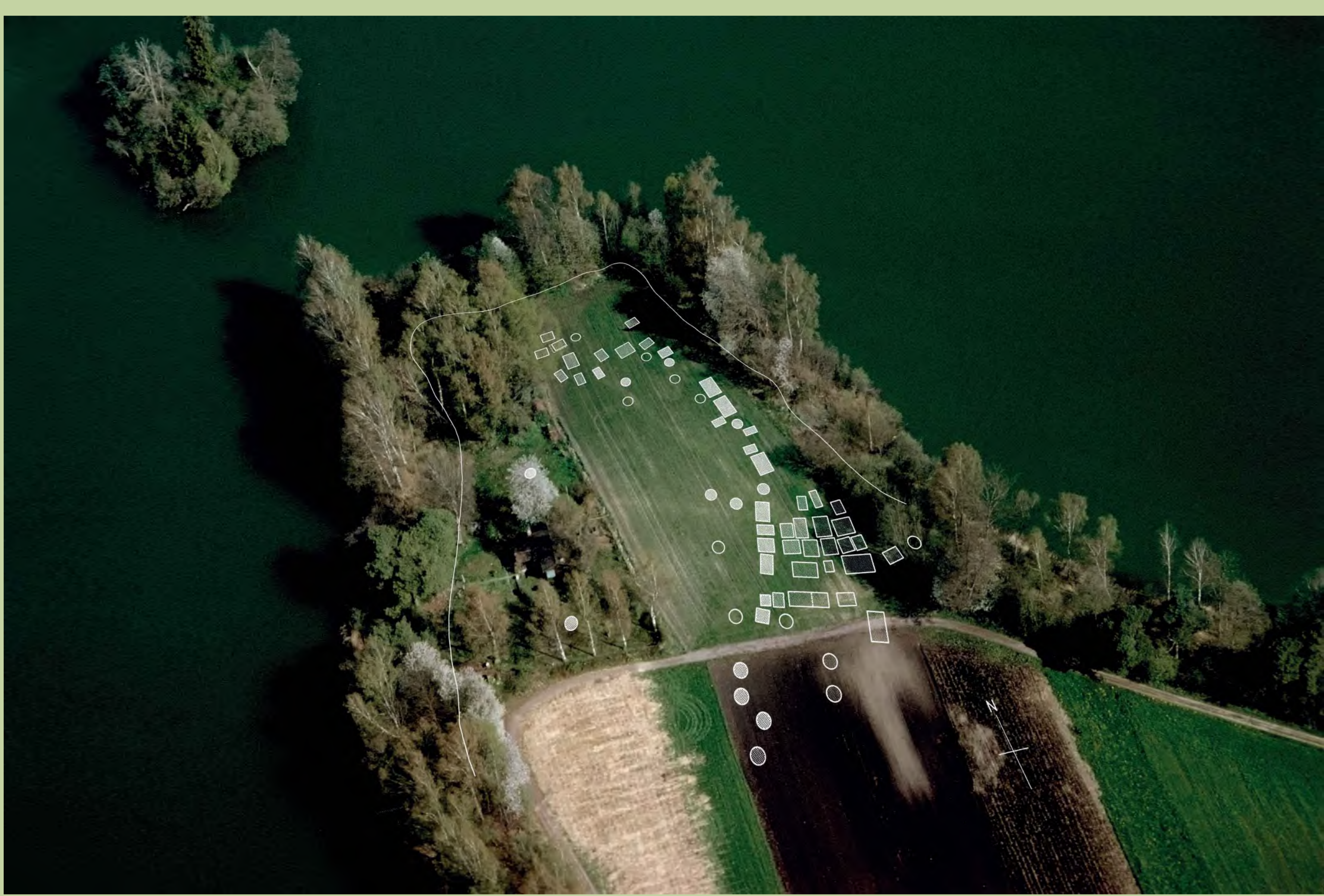
La presqu'île de Horn vue du ciel, en 1989, avec l'emplacement des bâtiments fouillés.
